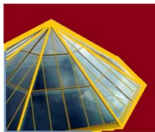
Рис. 1. Зенитный фонарь зимнего сада снаружи
